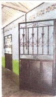
Foto 3: Mantenimiento a estructura en puertas de metal (lijado, cepillado, aplicación de pintura) y sustitución de chapa
