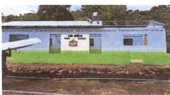
Foto1: Sustitución de lámina por lámina troquelada aluzinc, calibre 26 módulo 1
