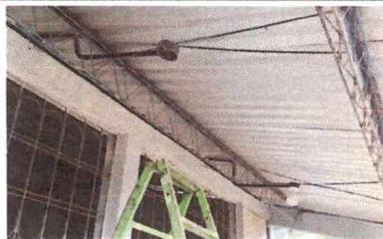
Foto 4: Reparación de Sistema Eléctrico
