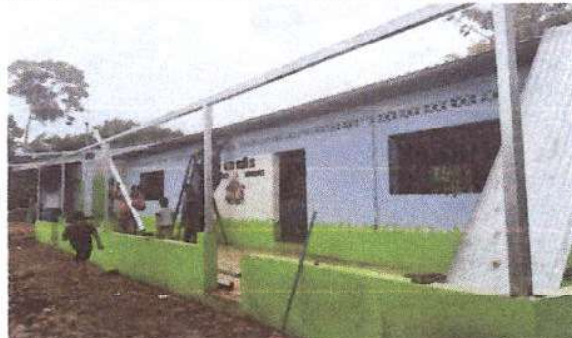
Foto 2: Sustitución de Estructura de soporte de madera, por soporte de metal módulo 1
